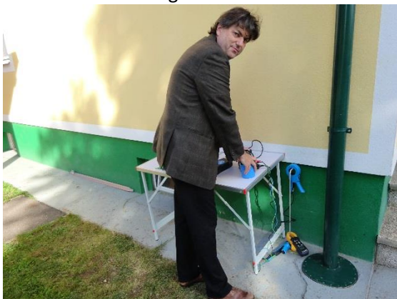
Erdungsmessung im Freien
